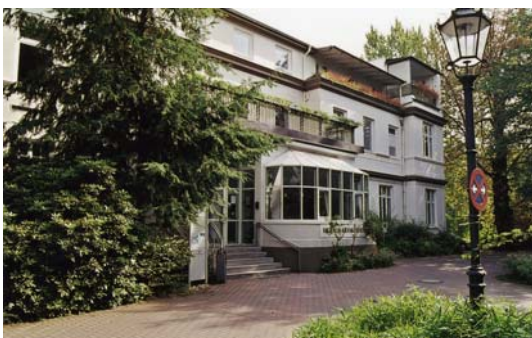
Eingangsbereich Haus B, Eichenstrasse
